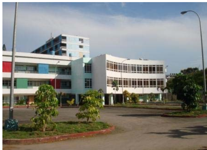
Figura 1. Cardiocentro quirúrgico “William Soler”. Detalle de la fachada principal.
